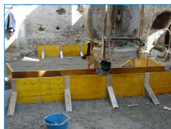
3 Preparazione del cordolo 3 Ring beam construction
